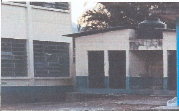
Foto 3: MANTENIMIENTO CISTERNA/DEPOSITO DE AGUA
